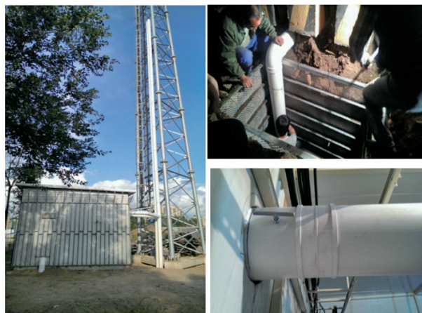
图10 改造机房现场施工照片
