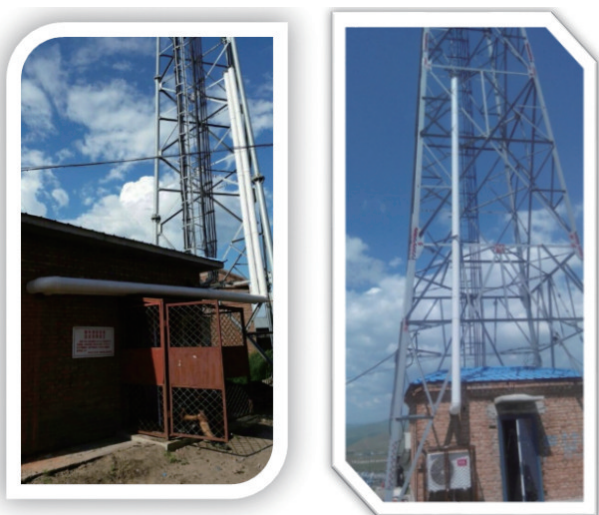
图8 自排热系统室外部分
