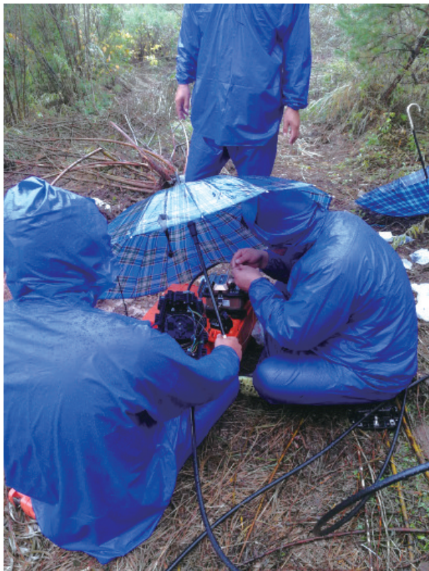
光缆抢修现场二
