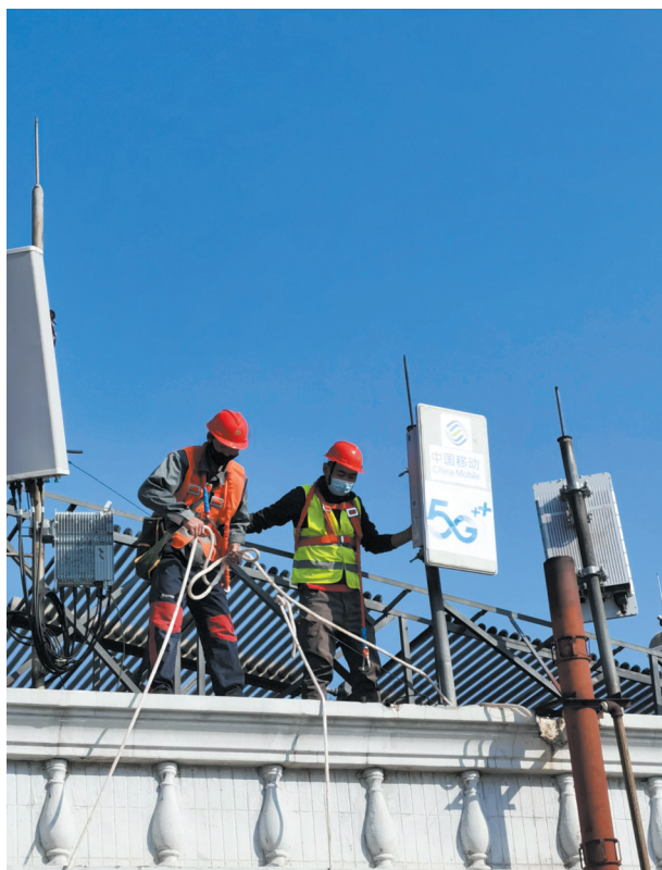
为疫情防控重点区域完成5G天线安装
